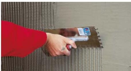
Армированный раствор необходимо наносить при помощи шпателя с зубьями 10x10 мм
