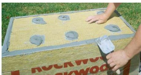
На плиты наносим клей на поверхность, как это показано на рисунке
