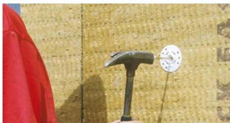
Крепление плит соединителями. Вставляем пластиковый соединитель и вбиваем легкими ударами молотком
