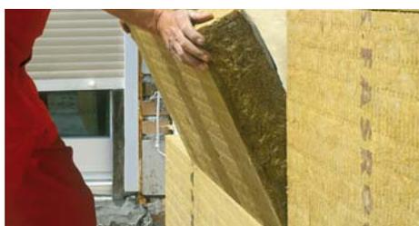
Излишки клеевого раствора со стороны плиты убираем так, чтобы они не были видны на стыках плит
