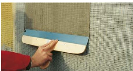
В свежий и одинаковой толщины армированный раствор утапливаем сетку из стекловолокна (сверху вниз) по всей высоте стены
